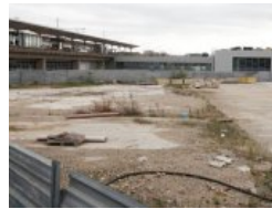
El Punt Avui - Adif frena l'inici de les obres al parc Central de Girona perquè no vol pagar l'enderroc del 'finger'
