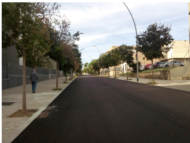
Figura 21. Carrer de Baldiri Reixac al Campus Diagonal Sud, després de les obres de transformació d'aquest vial en plataforma única. Banc d'imatges OSSMA.
